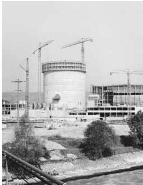
Erstes AKW der Schweiz: Reaktorbau in Beznau.
